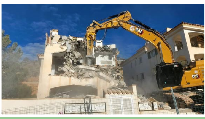
Imatge de la demolició dels apartaments il·legals de cala Llamp.
